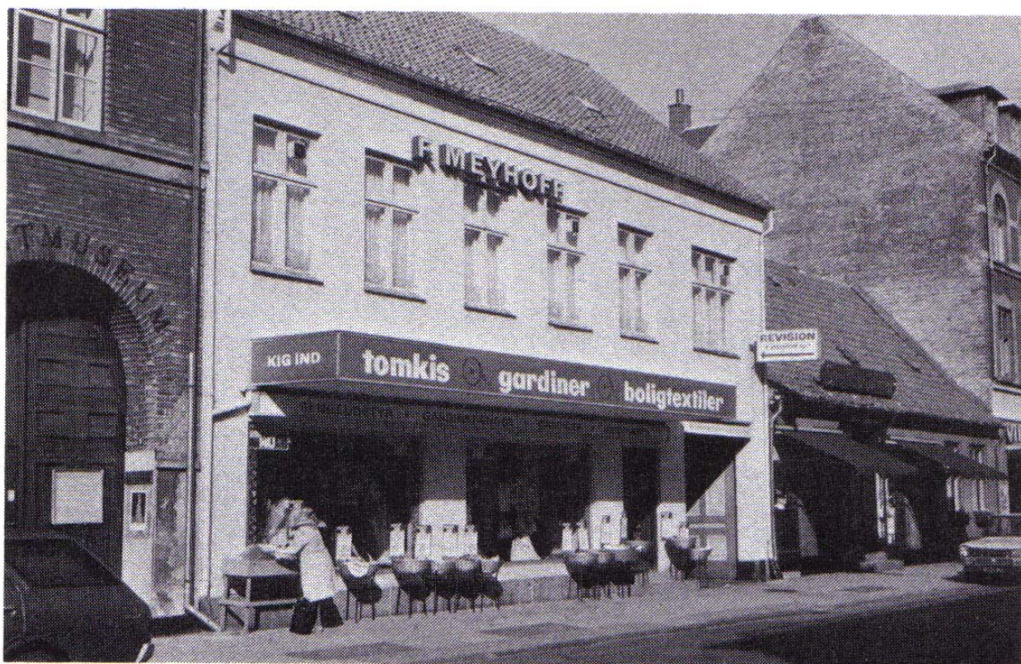
Fig. 43. Storgade 11–13, 1980. De to bygninger udgjorde oprindeligt en lang énetages bindingsværksbygning, se fig. 33 og 44.
